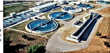
Επεξεργασία νερού στον Ασπρόπυργο
